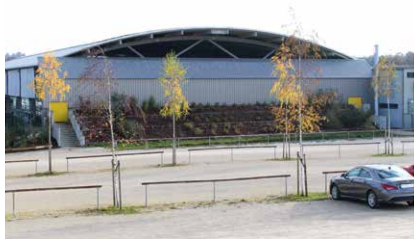
Das Eisstadion nach abgeschlossener Sanierung
