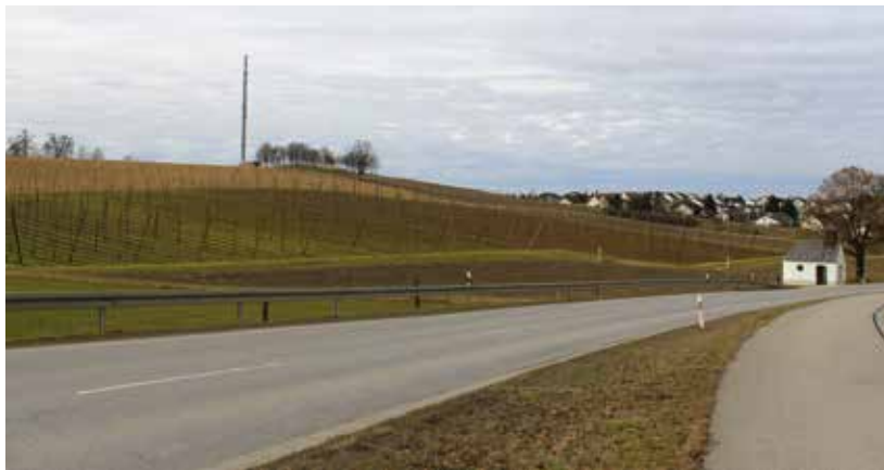
Das Baugebiet Pfaffelleiten an der Äußeren Moosburger Straße ist das derzeit größte Baugebiet, das zeitnah realisiert werden soll.
