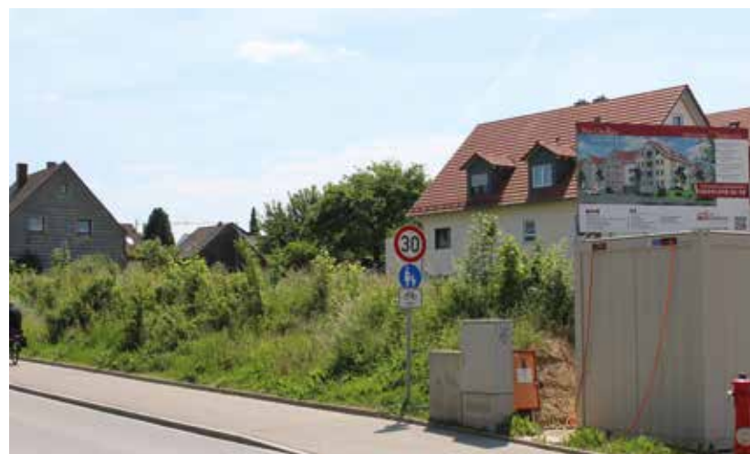
Im Baugebiet „Zwischen Oberfeldweg und Moosburger Straße“ vergibt die Stadt Pfaffenhofen sieben Eigentumswohnungen im Rahmen ihres Einheimischenmodells.
