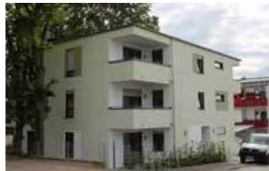
Das neue Mehrfamilienhaus an der Ziegelstraße 64 wird demnächst bezogen.
