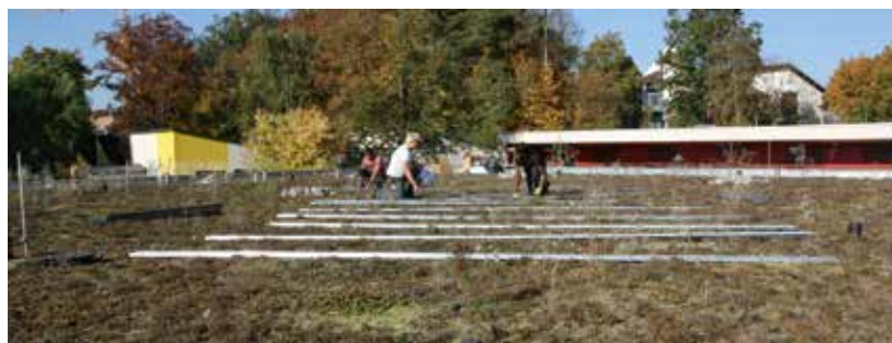
Auf dem Dach des Kinderhorts Don Bosco wird derzeit eine PV-Anlage installiert.
