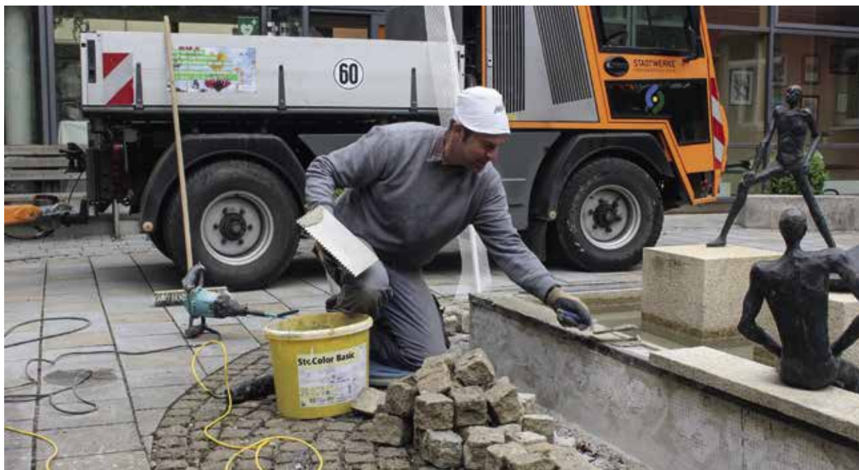
Mitarbeiter der Stadtwerke haben den Brunnen im Innenhof des Seniorenbüros erneuert.
