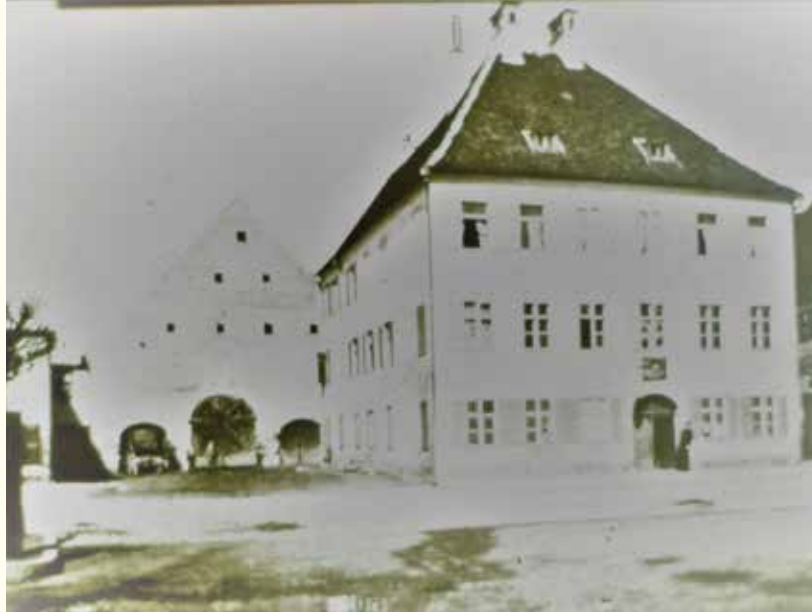
Das alte Landgerichtsgebäude mit dem dahinter befindlichen Bortenschlager-Stadel (um 1890)
